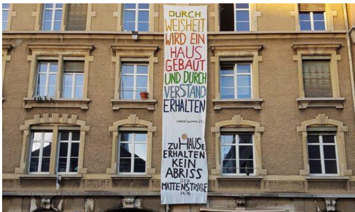
Mattenstrasse 74/76 in Basel-Stadt: Jüngste mieterfreundliche Hausübernahme durch die Genossenschaft Mietshäuser Syndikat, vollzogen auf den 1. März 2019.
