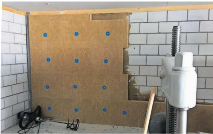
Für Aussenwände empfiehlt sich eine Schicht Holzfaserdämmplatten.
