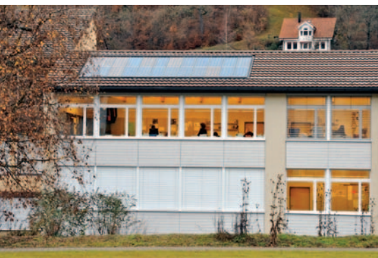
Die Pionieranlage der Solargenossenschaft Bauma auf dem Oberstufenschulhaus des Ortes wurde 1995 gebaut; die Module wandeln Sonnenlicht direkt in Elektrizität um.
