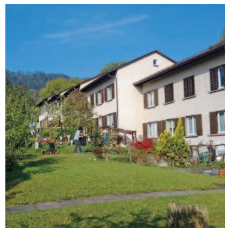
Die FGZ-Reihenhäuser an der Arbestalstrasse im Zürcher Friesenberg: energetische Prüfung vor der Sanierung.
