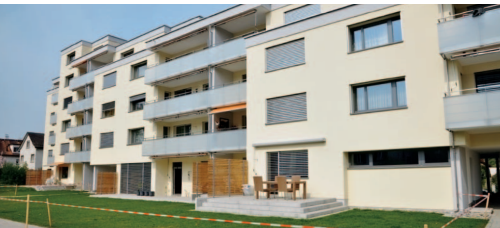
2009 sanierte die ASIG ihre Siedlungen Mattacker I und II in Zürich Seebach nach Minergie. Mit der Energieetikette wollte die Genossenschaft unter anderem überprüfen, ob die Energieziele erreicht worden waren.
