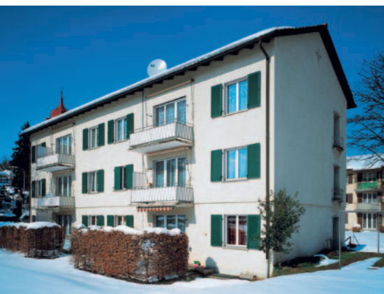
Neue Balkontürme mit Wintergärten lösen das Problem kleiner Balkone. Im Bild die Siedlung der BG Stern in St. Gallen vor und nach (grosses Bild links) der Sanierung.
