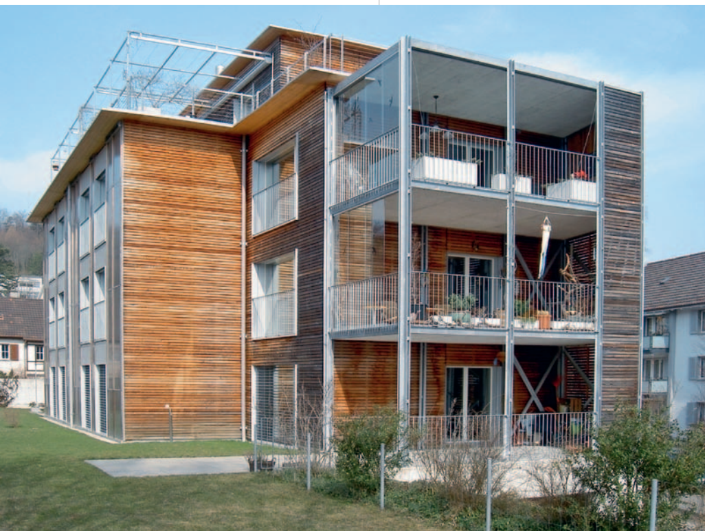
Eine Teilverglasung auf der Wetterseite verbessert die Nutzbarkeit des Balkons.
