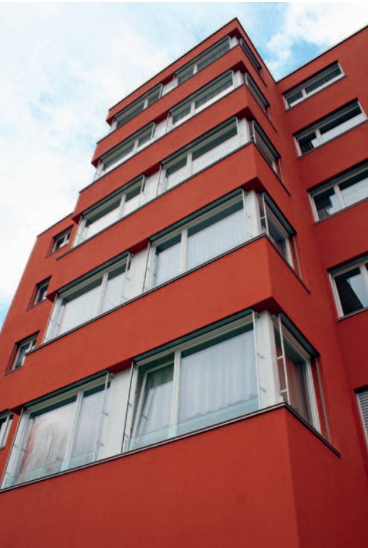
Neuen Balkon und mehr Wohnraum gewonnen: die Siedlung Käppeli der BG zum Stab in Muttenz (siehe auch Foto rechts) mit Balkonanbauten.
