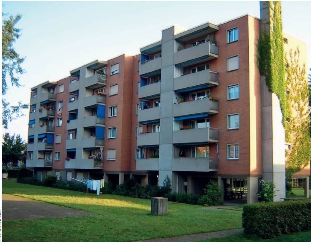
Bei einer Sanierung oft das Erste, das ansteht: kleine und schlecht isolierte Balkone. Im Bild die Siedlung Käppeli der BG zum Stab vor der Sanierung.
