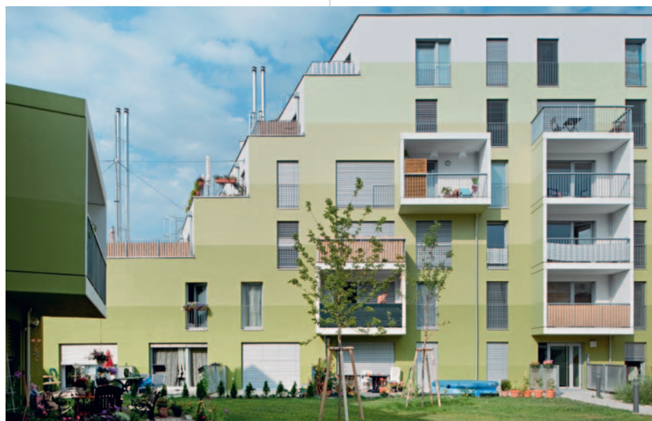
Private und gemeinsame Freiräume sorgen für viel Wohnwert.
