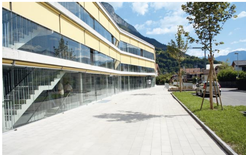
Die Sonnenstoren reagieren automatisch auf den Lichteinfall und verhindern zu hohe Temperaturen in den Begegnungszonen.
